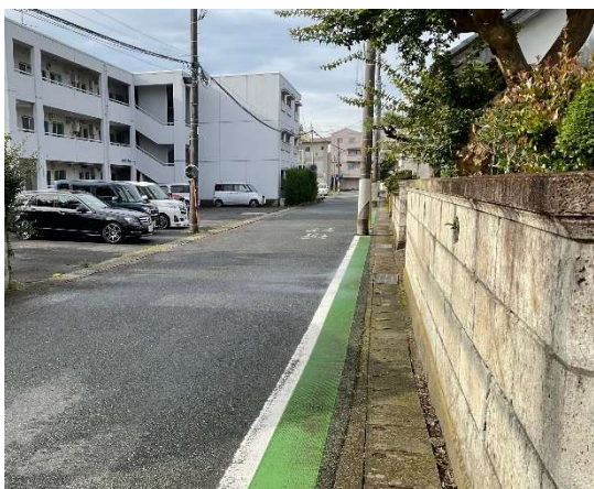
図-1 グリーンベルト上にある電柱
