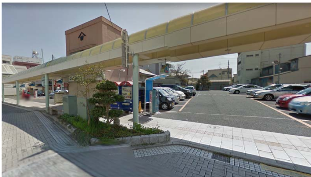
図 22.1 ユニット 3 施工前
